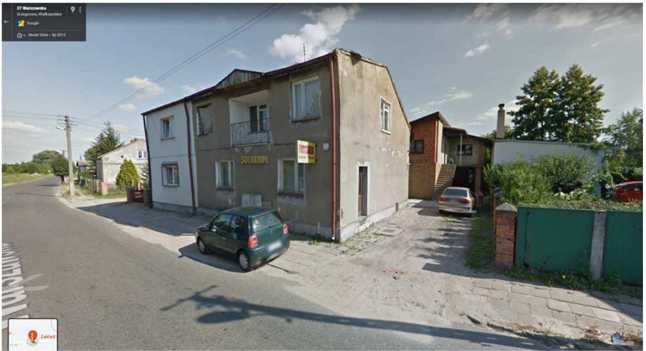
Widok na działkę przed rozbiórką budynku frontowego (w granicach historycznego układu urbanistycznego)
