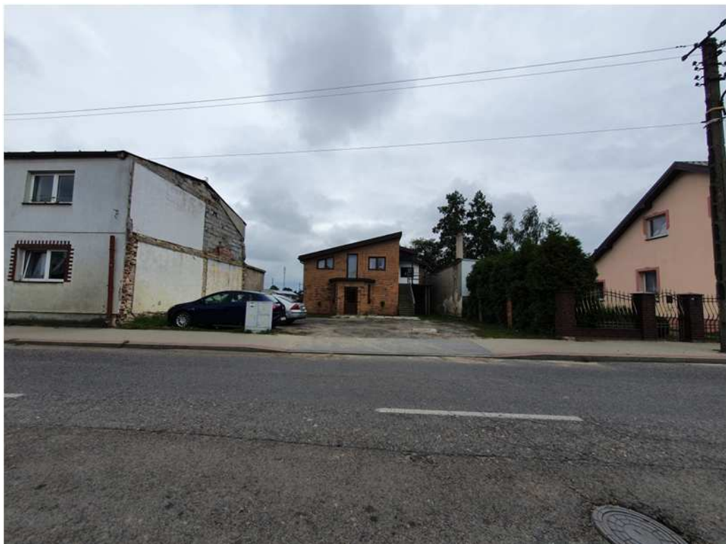
Aktualny widok z ulicy Warszawskiej na rozebrany budynek frontowy oraz znajdujący się w głębi nowy budynek
