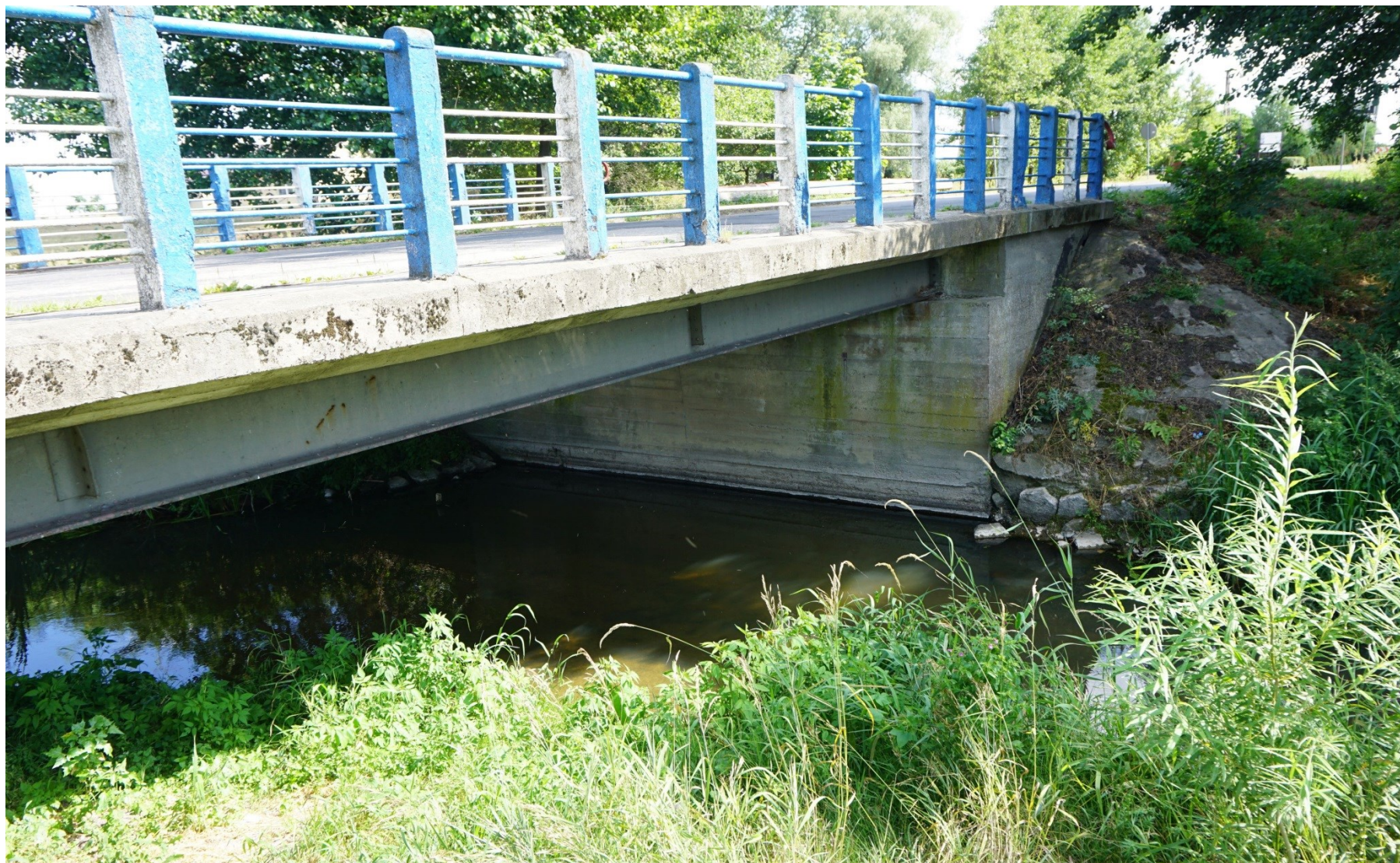
Przebudowa mostu na Rzece Rgilewce w Barłogach
