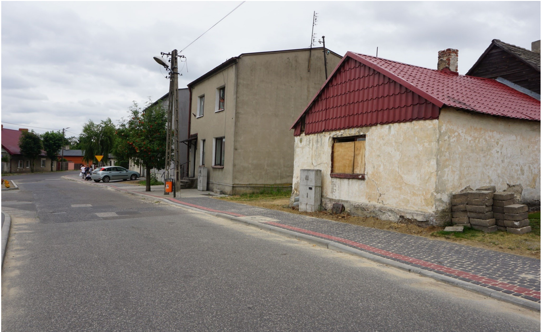
Budowa chodnika na ul. Szkolnej w Grzegorzewie
