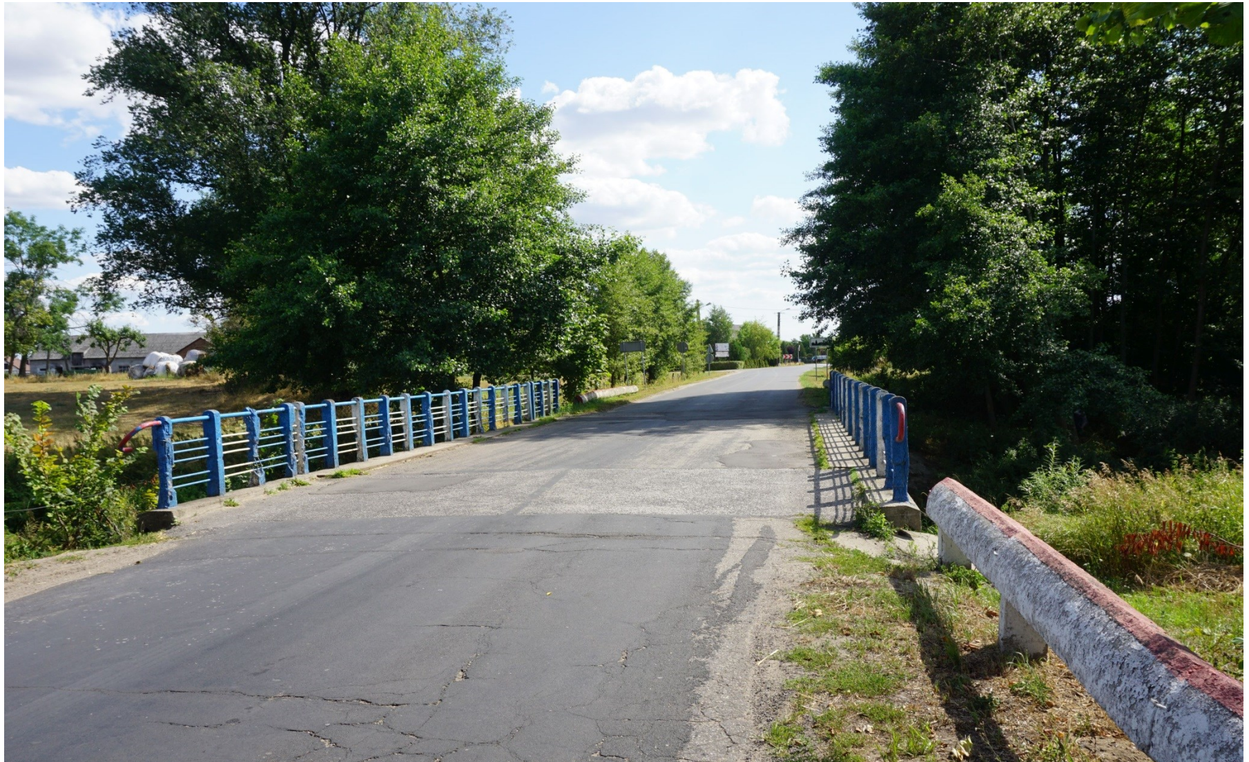
Przebudowa mostu na Rzece Rgilewce w Barłogach
