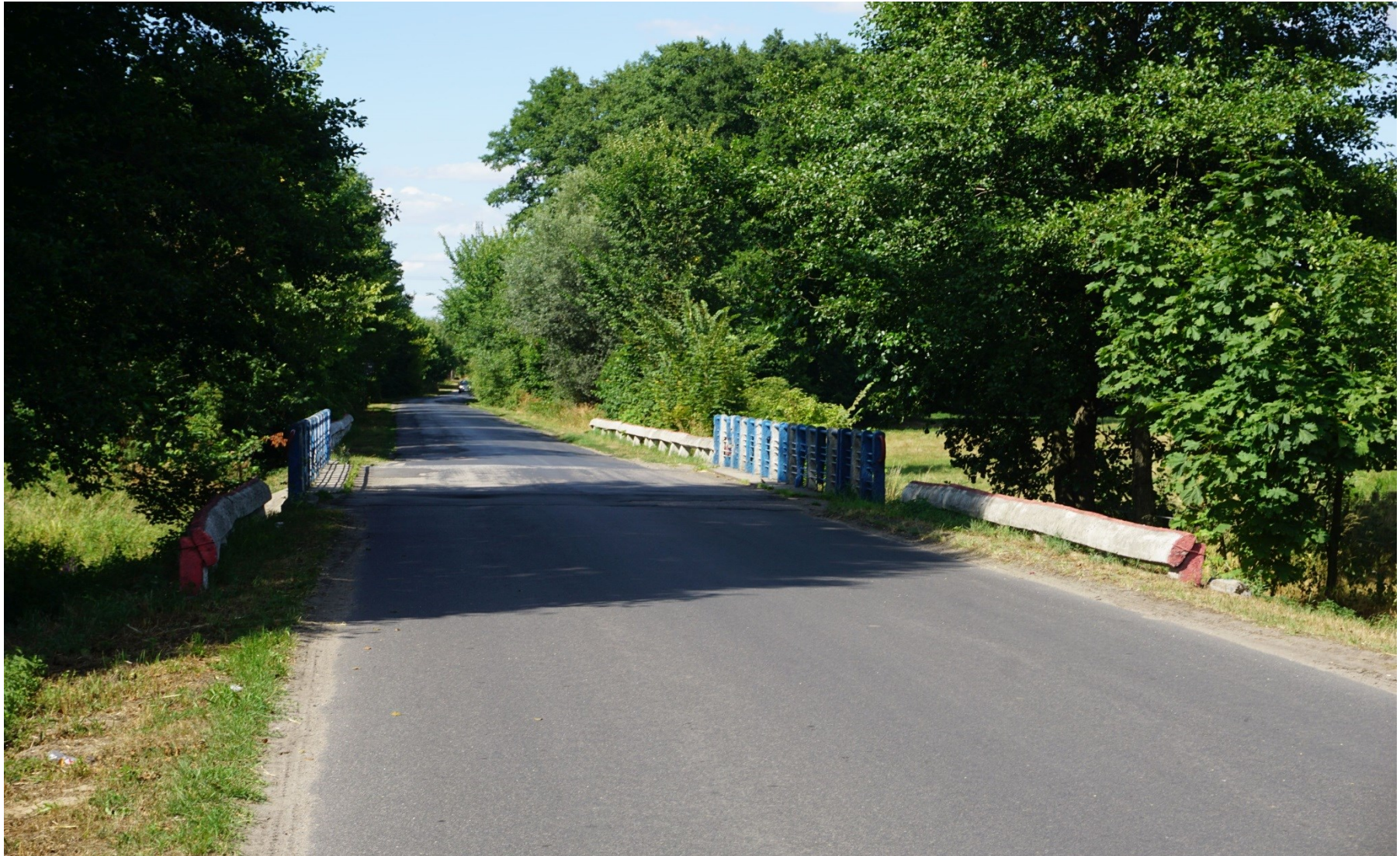
Przebudowa mostu na Rzece Rgilewce w Barłogach
