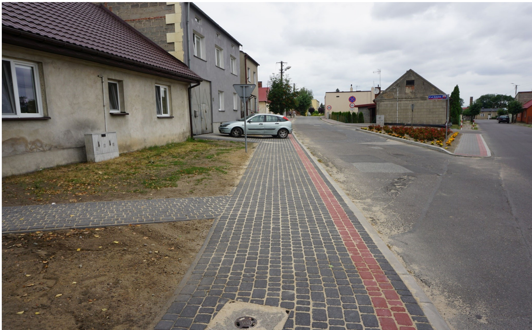
Budowa chodnika na ul. Szkolnej w Grzegorzewie
