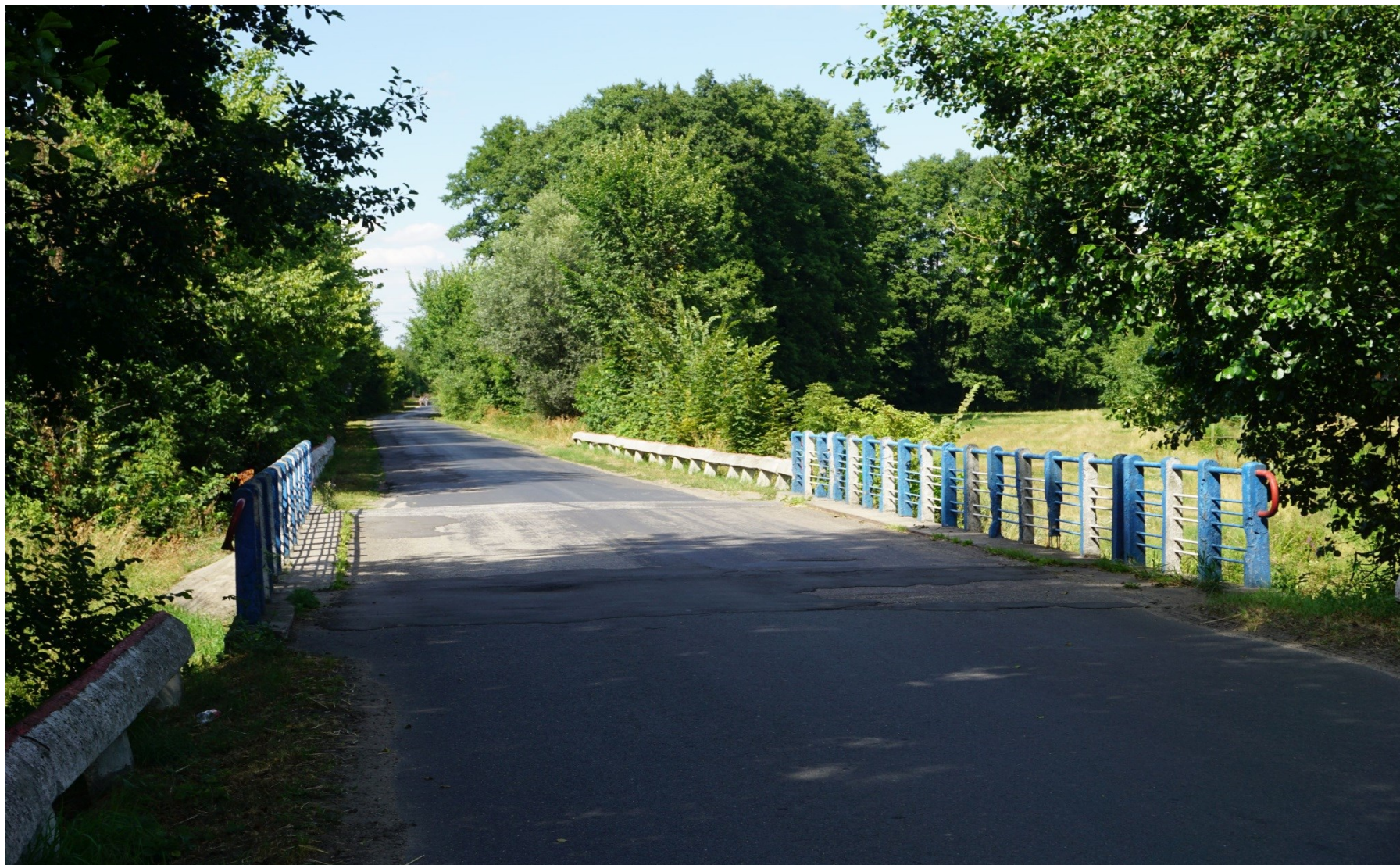
Przebudowa mostu na Rzece Rgilewce w Barłogach
