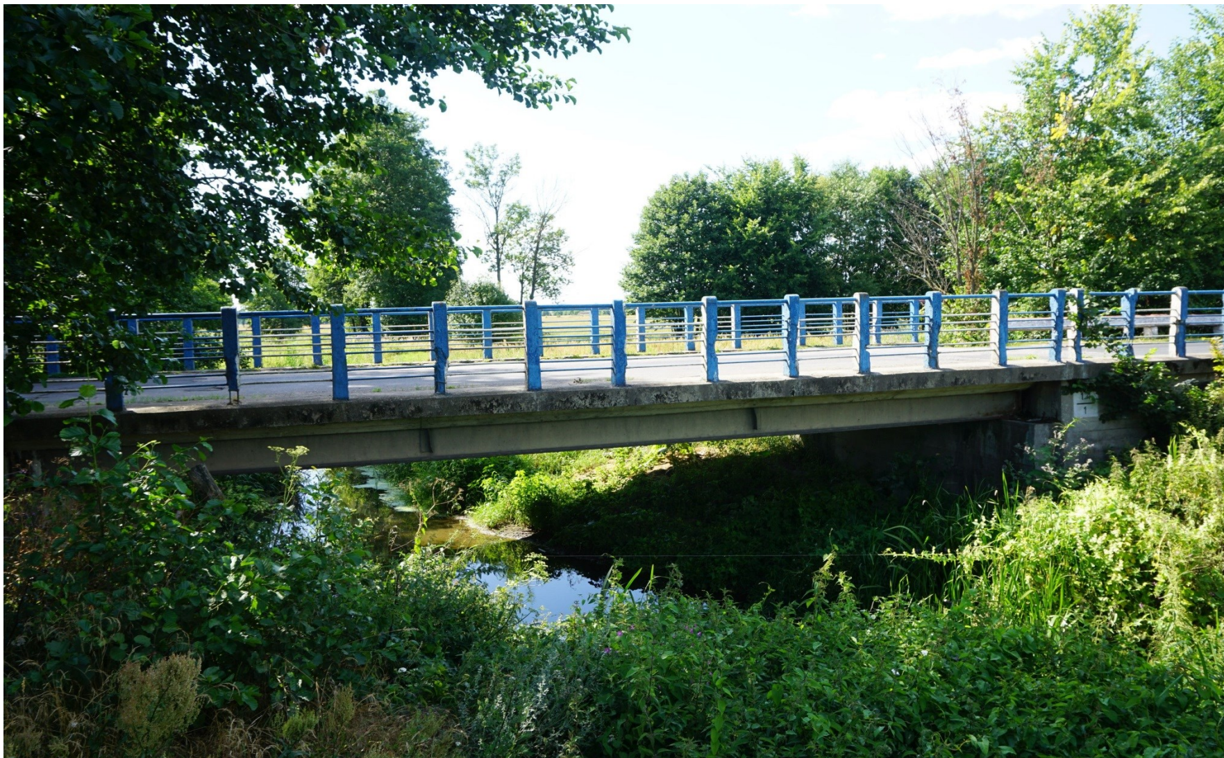
Przebudowa mostu na Rzece Rgilewce w Barłogach
