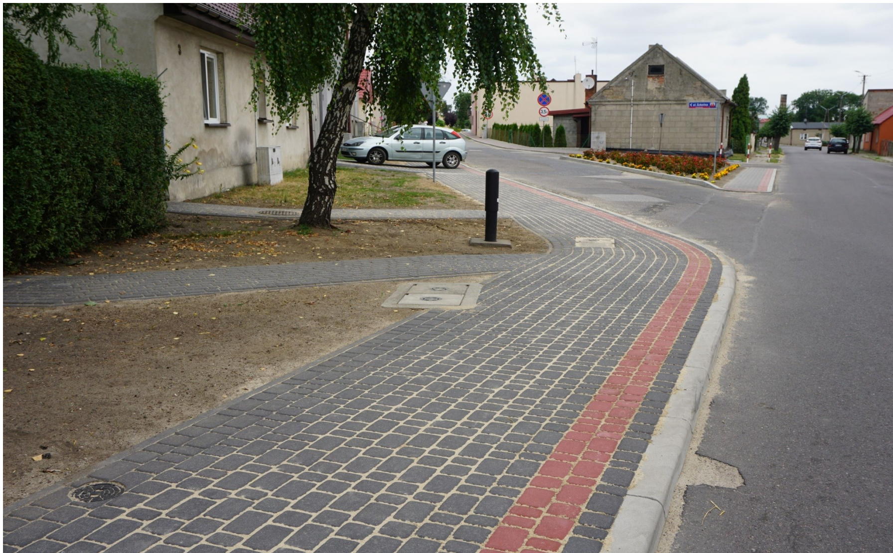
Budowa chodnika na ul. Szkolnej w Grzegorzewie
