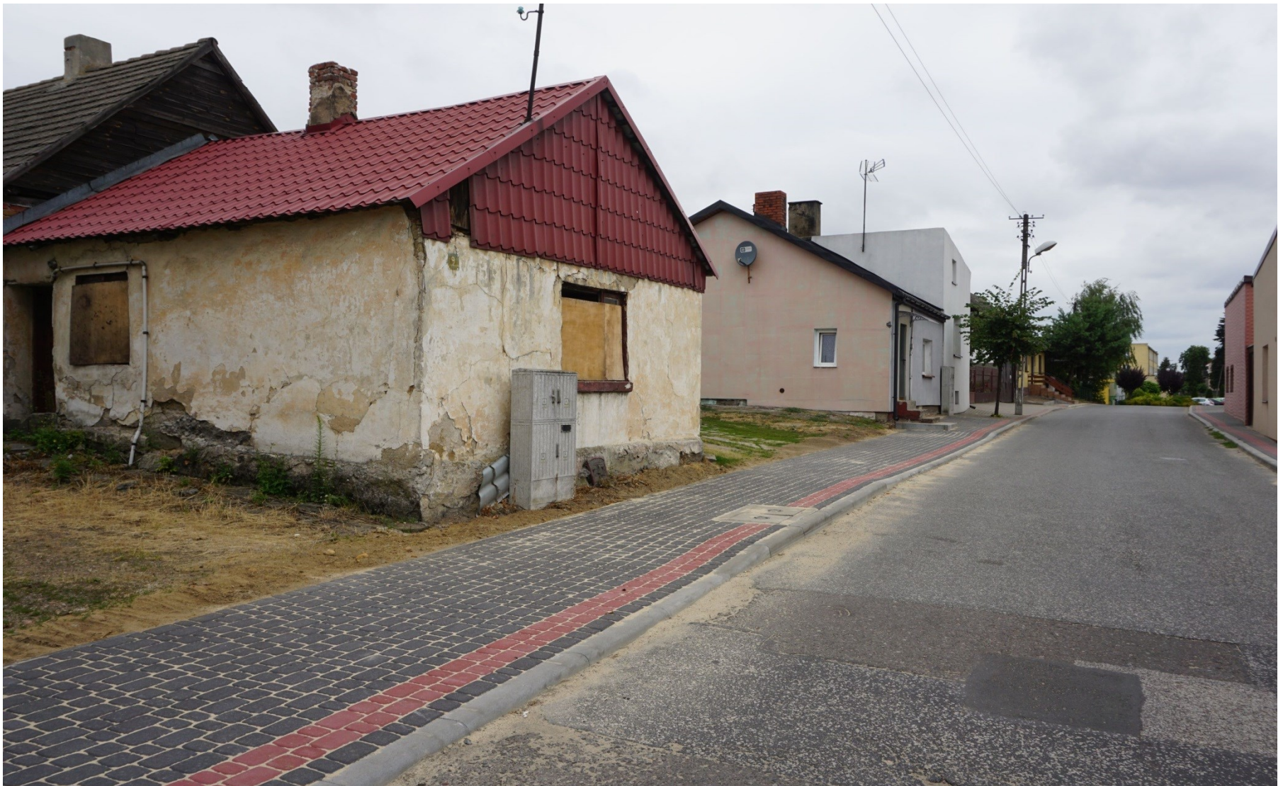
Budowa chodnika na ul. Szkolnej w Grzegorzewie
