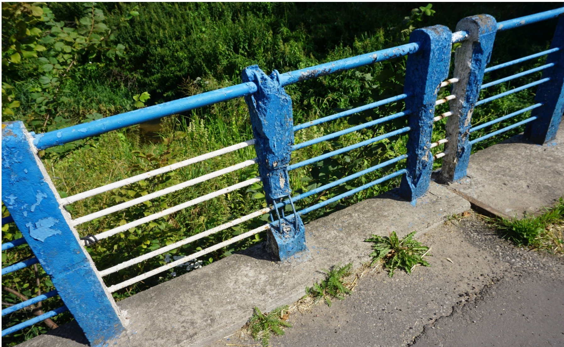
Przebudowa mostu na Rzece Rgilewce w Barłogach
