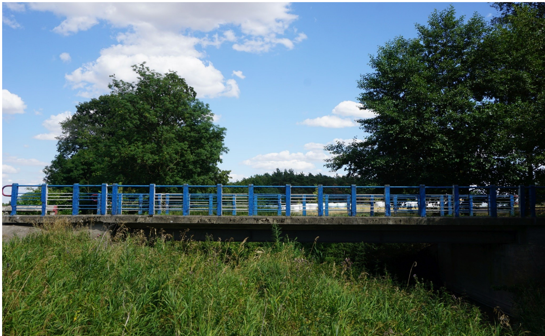
Przebudowa mostu na Rzece Rgilewce w Barłogach
