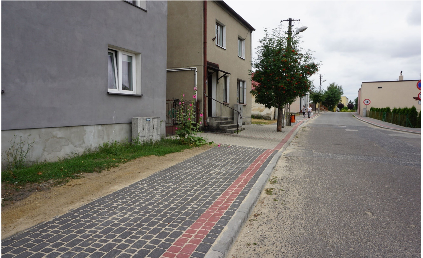
Budowa chodnika na ul. Szkolnej w Grzegorzewie
