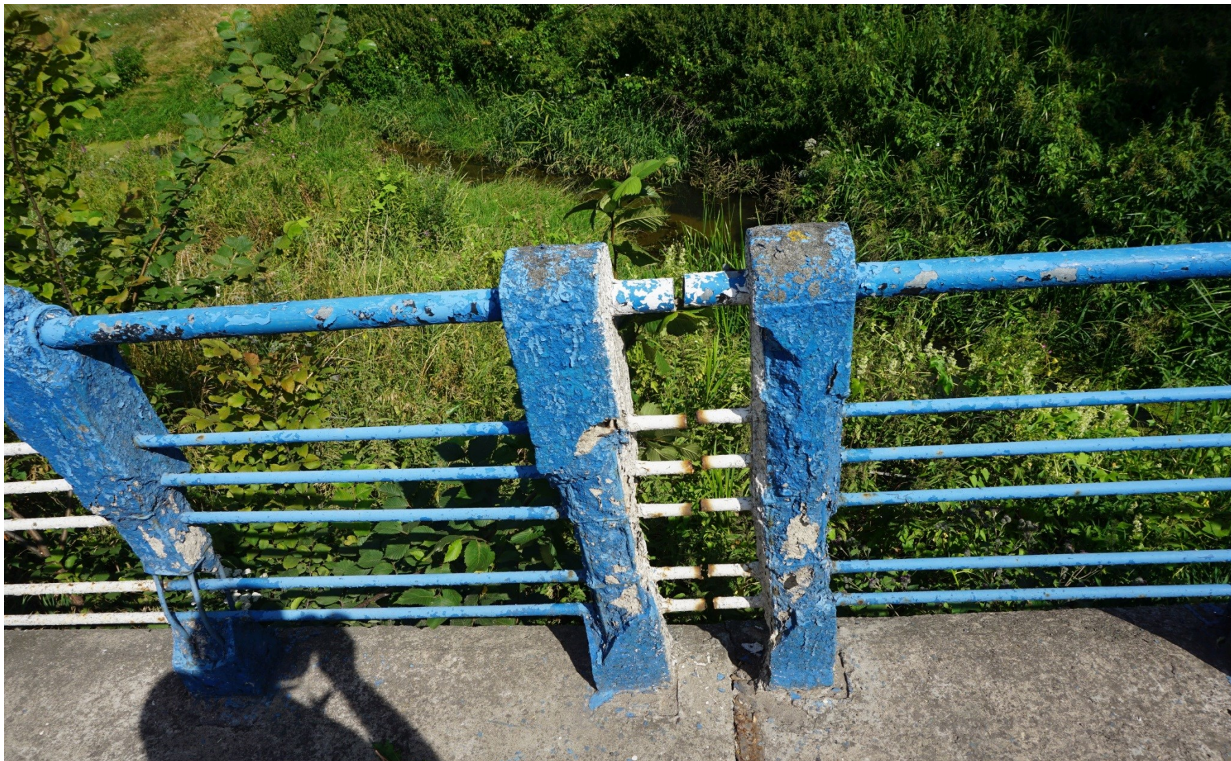
Przebudowa mostu na Rzece Rgilewce w Barłogach
