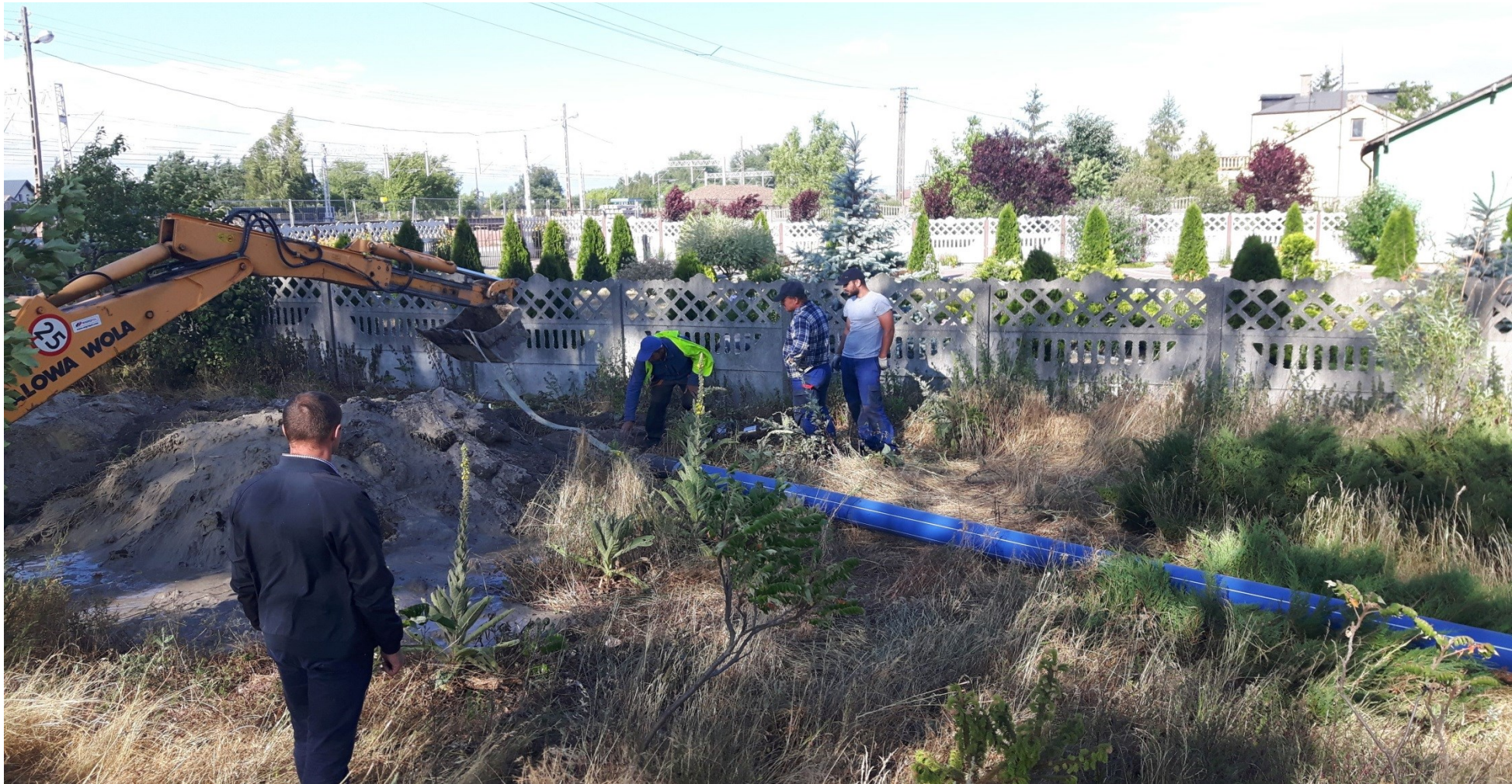
Budowa sieci wodociągowej Barłogi - Ponętów Dolny
