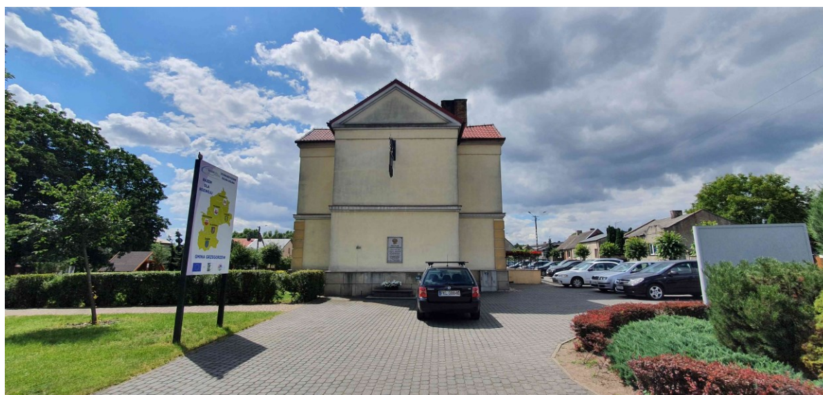
Fot. 3 Elewacja szczytowa północna
