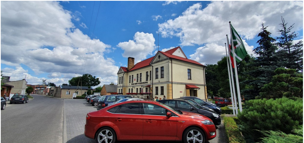
Fot. 4 Elewacja szczytowa południowa
