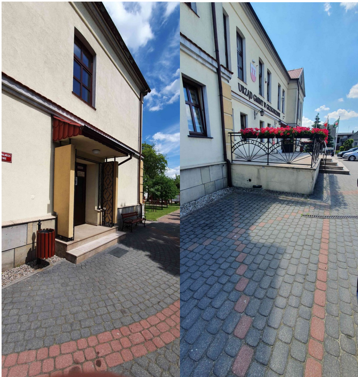
Fot. 9,10 Daszek wejściowy elewacja południowa. Miejsce przeznaczone na windę.
